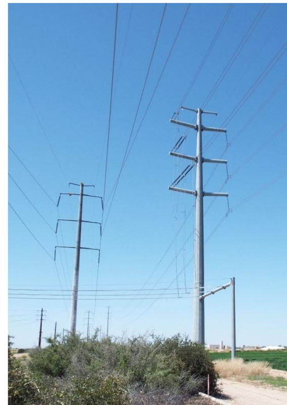
230kV Cut-In / 230kV Tangent
